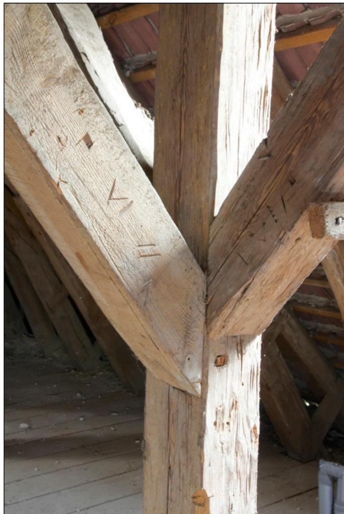
Unteres Schloß, Stuhlsäule im Dachwerk mit unterschiedlicher Bezeichnung für Quer- und Längsaussteifung
