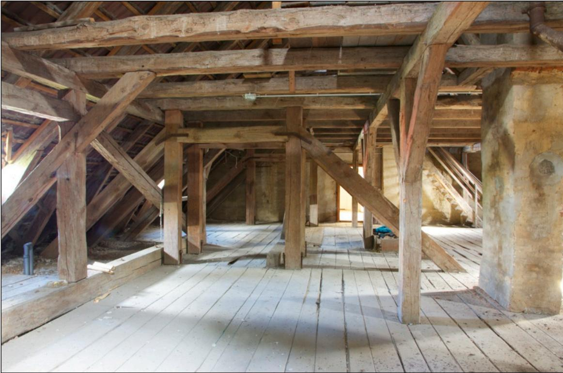
Unteres Schloß, Norddach, Blick nach Süden, Überzüge und Hängesprengwerke zur Abtragung der Lasten über der „Aula“
